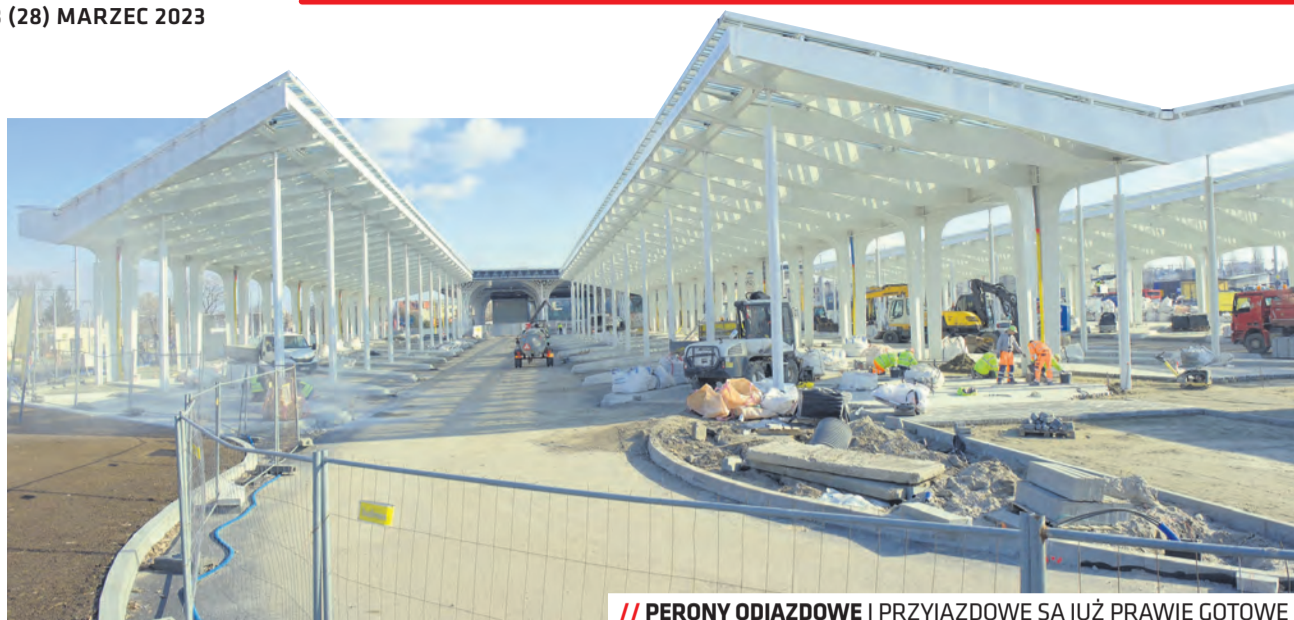
// PERONY ODJAZDOWE I PRZYJAZDOWE SĄ JUŻ PRAWIE GOTOWE
