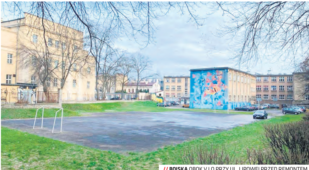
// BOISKA OBOK V LO PRZY UL. LIPOWEJ PRZED REMONTEM
