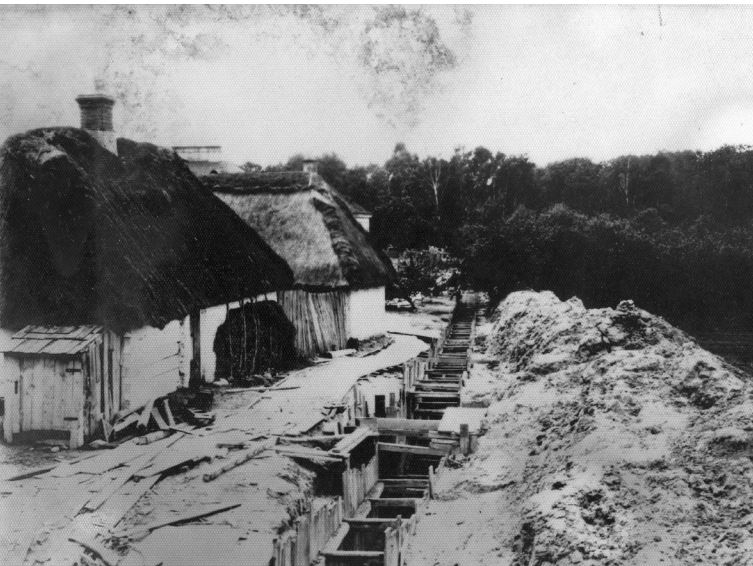
ZABUDOWA RUR W OKRESIE MIĘDZYWOJENNYM, FOTOGRAFIA ZE ZBIORÓW MPWIK, 1927, PRZEDSTAWIAJĄCA BUDOWĘ WODOCIĄGU ZE STUDIŃ NA WROTKOWIE DO LUBLINA.
