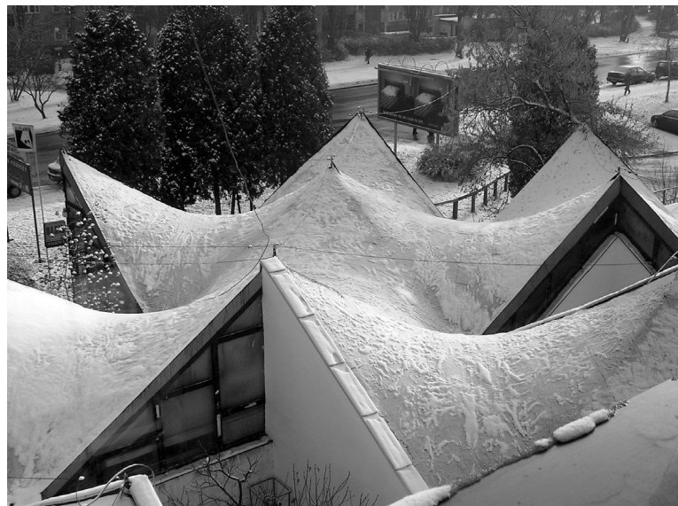
PARABOIDALNE PRZEKRYCIA PROJEKTU O. HANSENA
